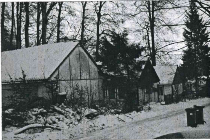
Abb. 12: Ansicht der Südfassaden Haus II bis IV, errichtet in typischer DDR-Leichtbauweise (Foto: H. SCHÜTT).
