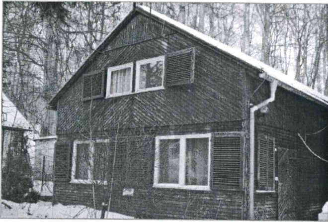
Abb. 8: Ansicht von Süden Haus I, Gebäude mit vorgeblendeter Holzfassade (Foto: H. SCHÜTT).
